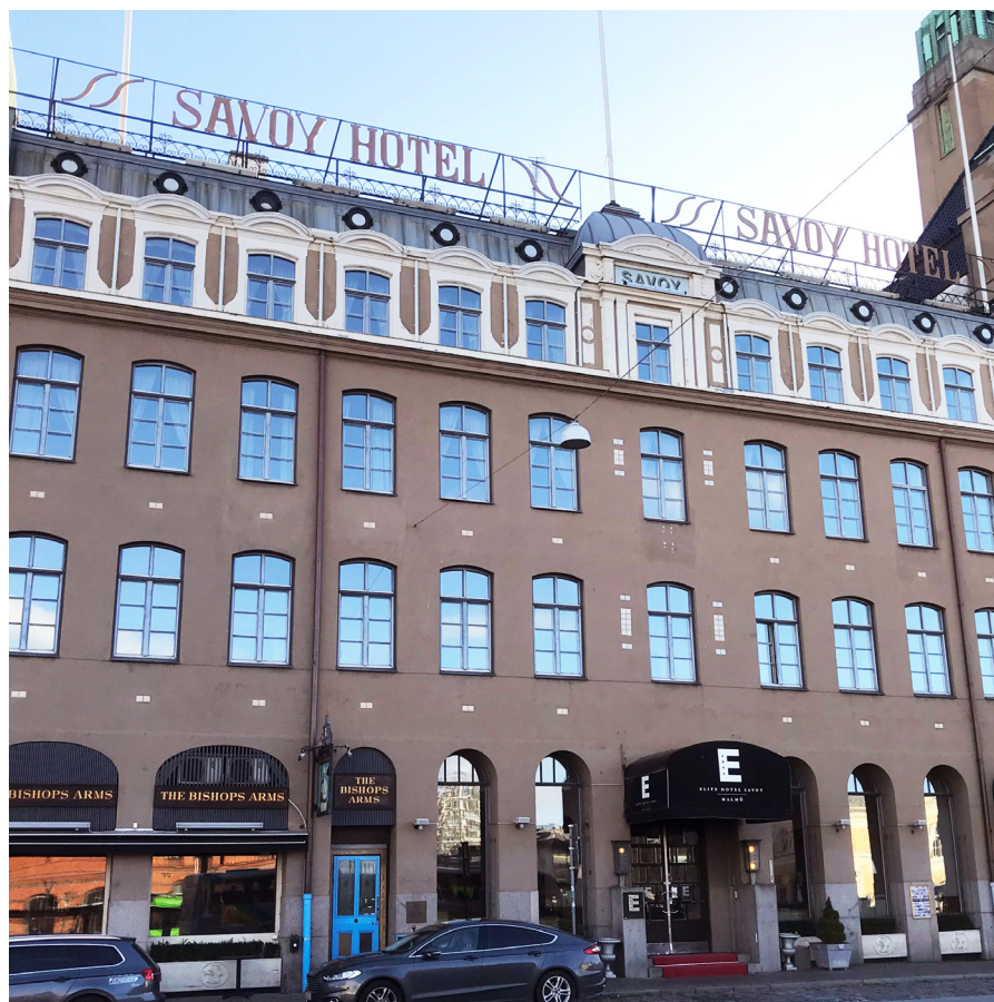
Rörläggaren, El-Pågarna och VFB är med i renoveringen av Hotell Savoy i Malmö.
