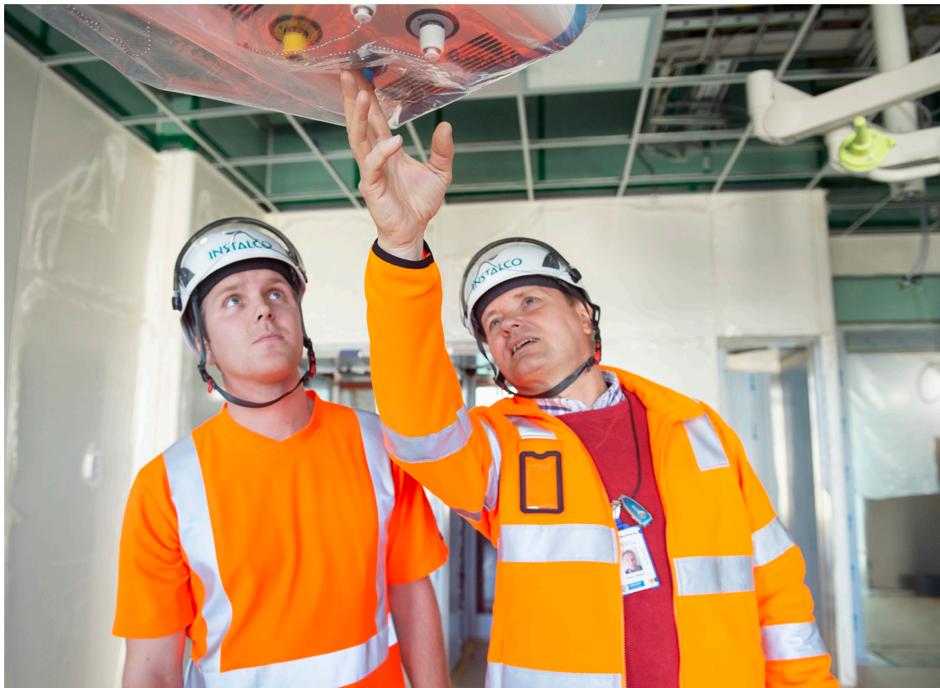
Rörgruppen, Ohmegi, El & Säkerhet, JN El, Sprinklerbolaget och LG Contracting är de Instalco-bolagen som är med i projektet.
